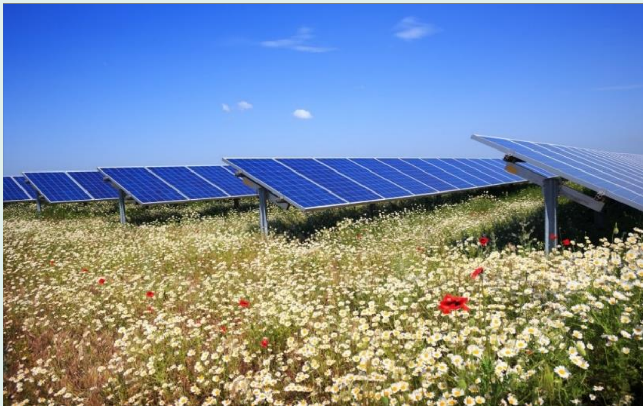
Figur 3: Eksempel på bunddække under og imellem solcellepaneler.
